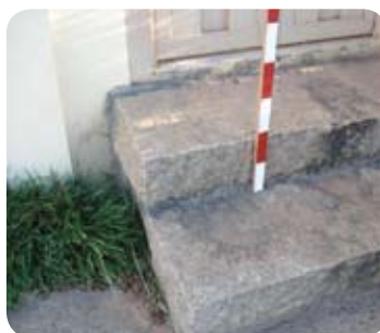
Degraus na entrada
