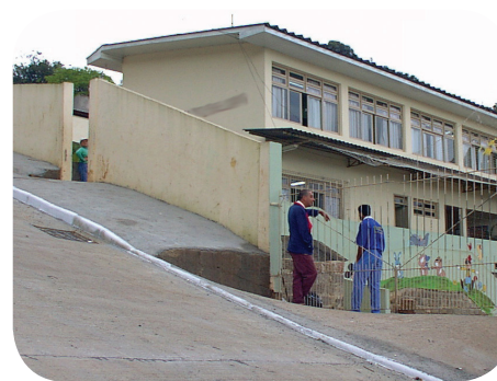
Entrada de escola em rua extremamente inclinada Fonte: Acervo autoras.
